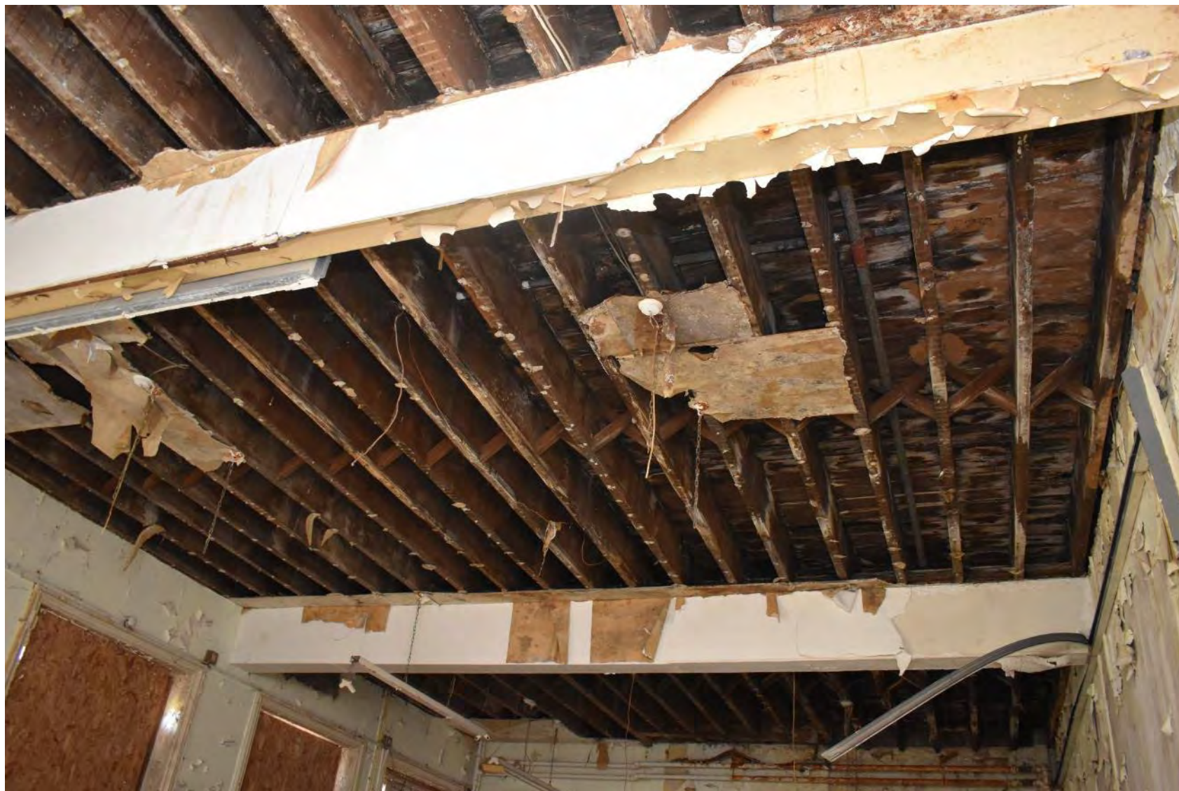
Plate 70: Room D ceiling(August 2021)
