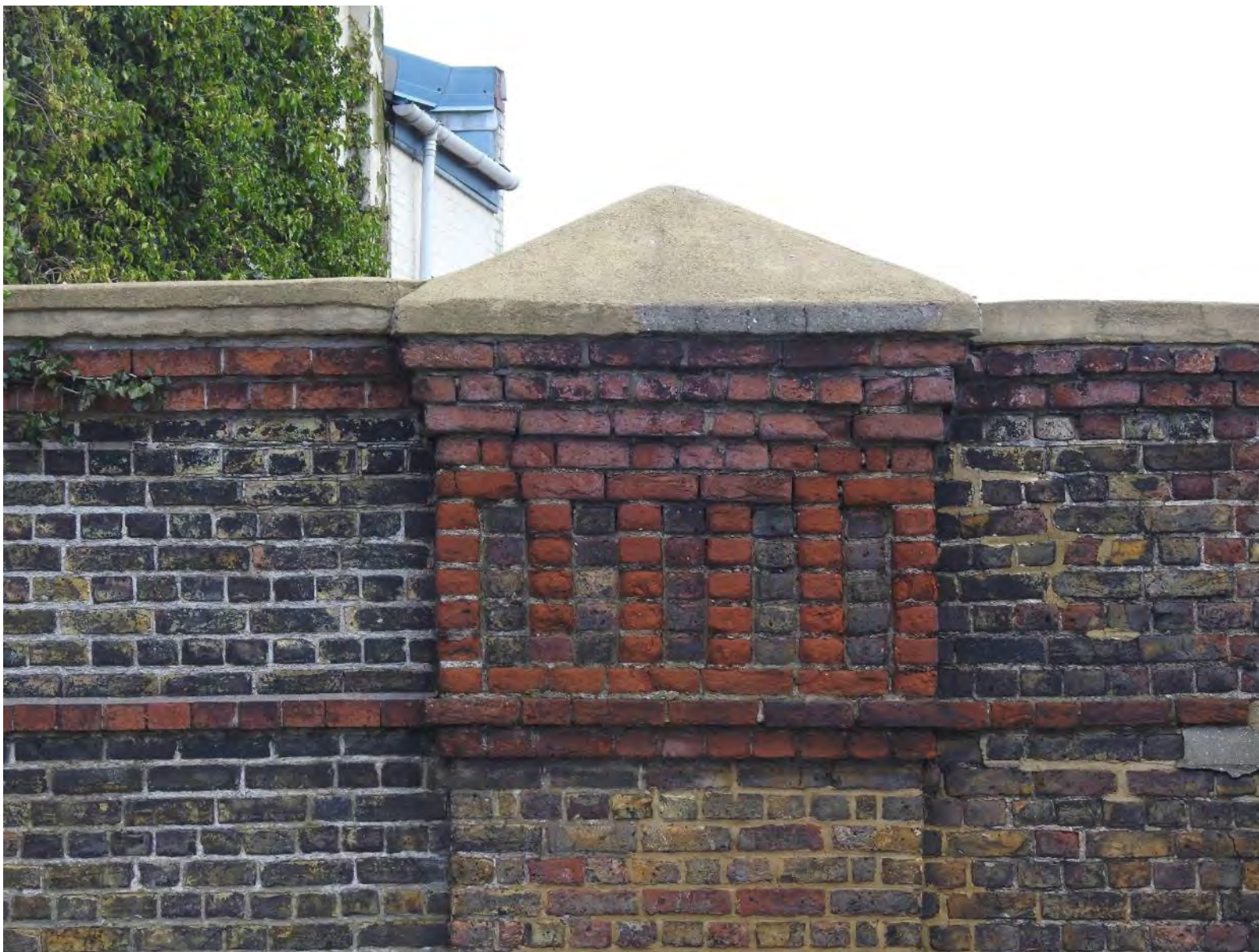
Plate 47: Wall detail (August 2021)
